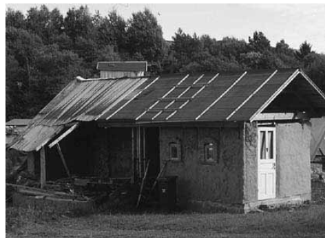
Figur 4. Servicebyggnaden vid Skärkälls andelsförening under återuppbyggnad efter en brand som slukade byggnadens brännbara delar.
