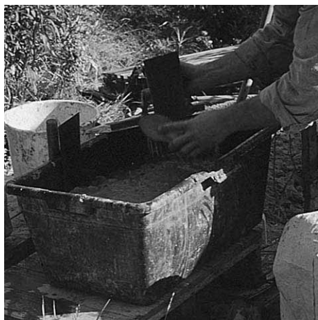
Figur 8:2. Här diskas ett bräde som använts för lerputsning. Till rengöring av redskap och verktyg krävs inga starkare rengöringsmedel än vatten.
