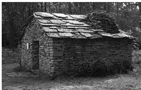
Figur 8:5. Kallmurad smedja uppförd i kalksten från 1700-talets första del. Flyttad till Estlands friluftsmuseum utanför Tallinn 1964.
