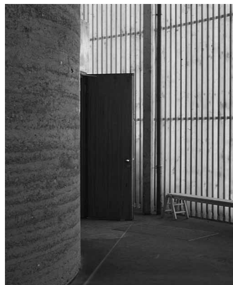
Figur 39. Väggen som omsluter kyrkrummet är utförd i stampad lerjord av det österrikiska företaget Lehm-Ton-Erde.
