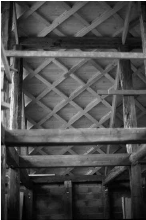
Figur 18. I förgrunden syns bärverk i trä för loftet och de mallar som formar taket, som har en annan konstruktionslösning med ett flätverk av trä som bildar en skalkonstruktion.
