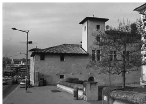
Figur 33. Hus med torn i Lyon vid Rue du sergent Michel Berthet.
