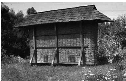
Figur 8:3. Korgflätad majstork från friluftsmuseet i Uzhorod, västra Ukraina. Slanorna kan flätas i olika mönster. Träspån på taket.
