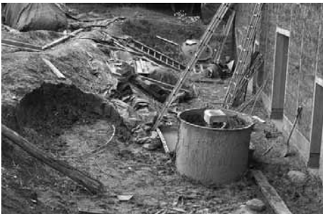
Figur 20. Leran till lerhalmsvägg och puts fanns tre meter från tillredningsplatsen.
