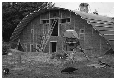
Figur 19. Under sommarhalvåret 1998 uppfördes tak och lerhalmsväggar, men först året därpå kunde kretsloppshuset tas i bruk.
