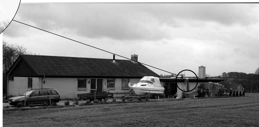
Figur 4:3. Utsug och motor till köksfläkten har här monterats på så stort avstånd som möjligt från spisen.
