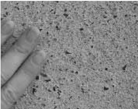
Figur 7. Sanitetshusets ytterväggar har putsats med murarkalk med svart sten som borstats fram. Den svarta ballasten tillsattes för att ge väggen en färg och struktur som är behaglig för ögat. Invändigt har teknisk kalk, som är lättare att få tag på, använts.
