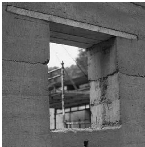
Figur 6. Över fönsteröppningen har kraftiga brädor placerats för att föra ner taklasterna vid sidan om fönstret. Här har horisontell formsättning praktiserats, vilket framgår av de fyrkantiga öppningarna i väggen. I fönsteröppningen syns en tydlig horisontell fog efter formskiftet.
