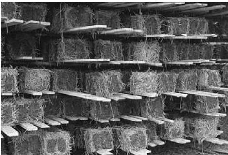
Figur 12. Några av de drygt 7 000 lerhalmsblock som tillverkades till kyrkbygget.
