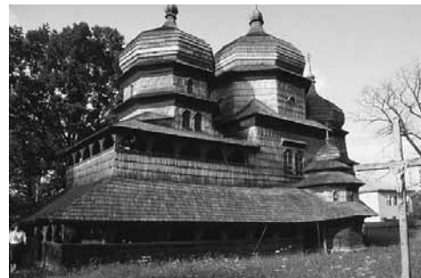
Figur 8:6. S:t Georges träkyrka från 1600-talet är beklädd med träspån. Drohobyc, sydvästra Ukraina.
