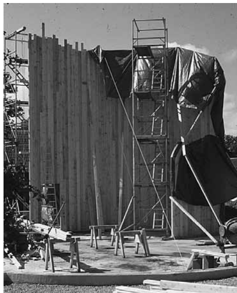
Figur 11. De 8 - 9 meter höga stående planken börjar ge kyrkan dess form.
