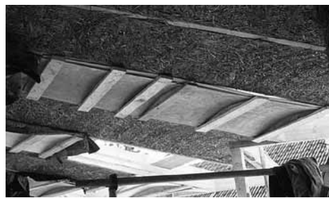
Figur 13. I foajéns tak packades lerhalmen från sidan, vilket är ett mycket tungt och arbetsamt förfarande. Här kom man fram till att valvet behöll sin form bättre om packformen fick sitta kvar över natten. För att formarna skulle vara lätta att ta bort kläddes de med plast.
