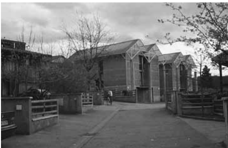
Figur 35. Två trevåningshus av arkitekterna Françoise Jourda och Gilles Perraudin med värmepumpar under den dubbla sadeltakskonstruktionen.
