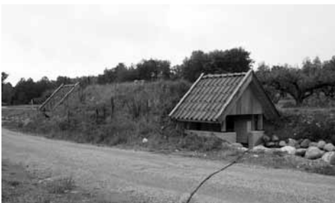
Figur 28. Pumphuset som förser byggnaderna med vatten är inrättat i en gemensam jordkällare.
