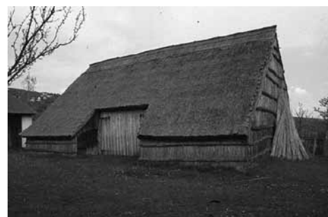
Figur 8:4. Lada vid det ungerska friluftsmuseet utanför Budapest. Tak och väggar är gjorda av vass.
