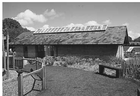
Figur 8:7. Den nybyggda servicebyggnaden vid Norden Park and Ride i Dorset är ett mackelerat hus med en hög stensockel.
