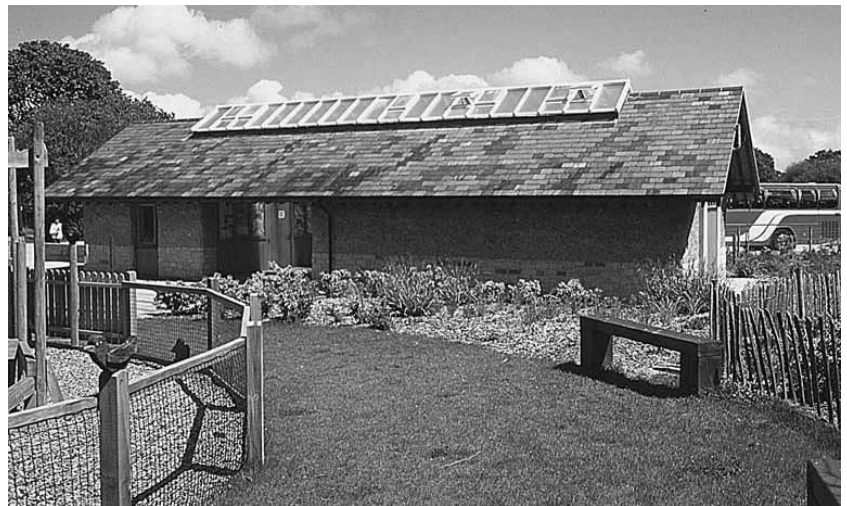
Figur 37. Den nybyggda servicebyggnaden vid Norden Park and Ride i Dorset, ett mackelerat hus med en hög stensockel.
